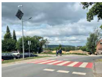
Zakończyła się budowa trzech nowych przejść dla pieszych – strona 2
