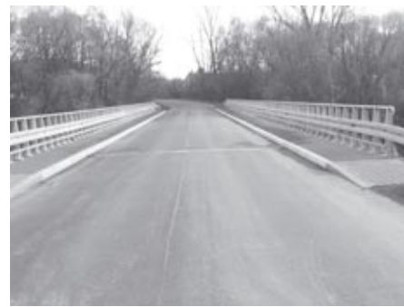
i po remoncie
