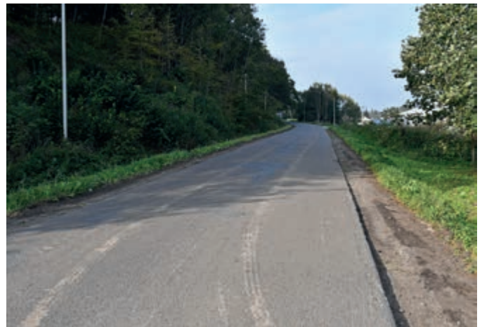
Droga powiatowa w Lubatówce w trakcie remontu
