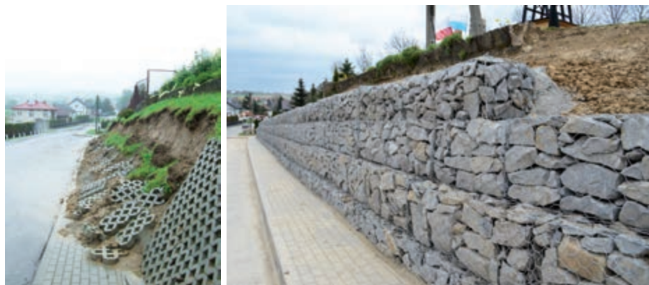
Skarpa przed i po przebudowie
