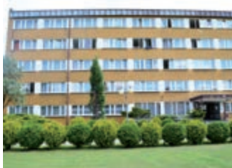
Internat przy ZS w Iwoniczu przejdzie termomodernizację – strona 9
