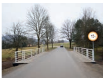
Most w Tylawie już przejezdny – strona 4
