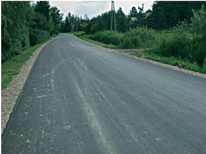
Nowa nawierzchnia na odcinku drogi w Kopytowej
