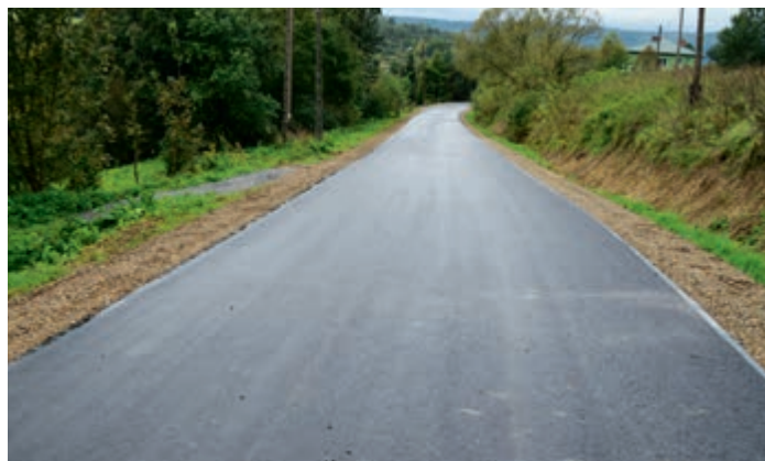
Remont drogi w Zawadce Rymanowskiej – remont trwa
