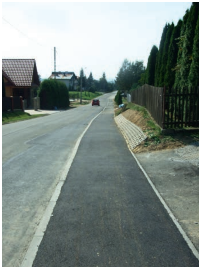
Przebudowa drogi wraz z budową chodnika w Odrzykoniu
