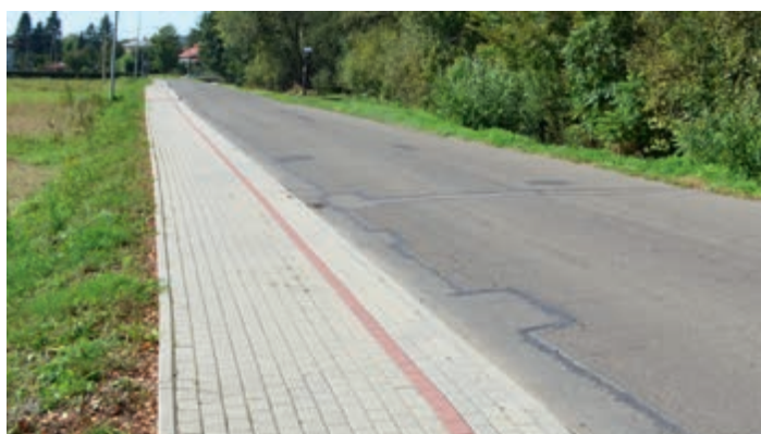
Budowa chodnika w Przybówce
