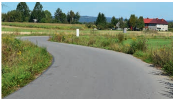
Nowa nawierzchnia w Jaszczwi
