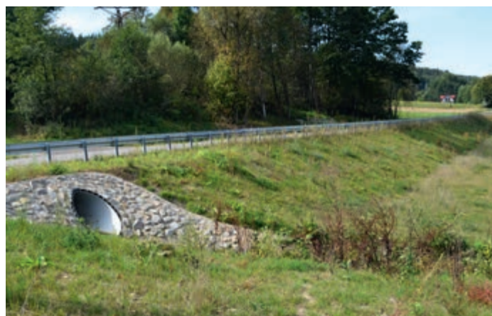
Stabilizacja osuwiska w Pietruszej Woli
