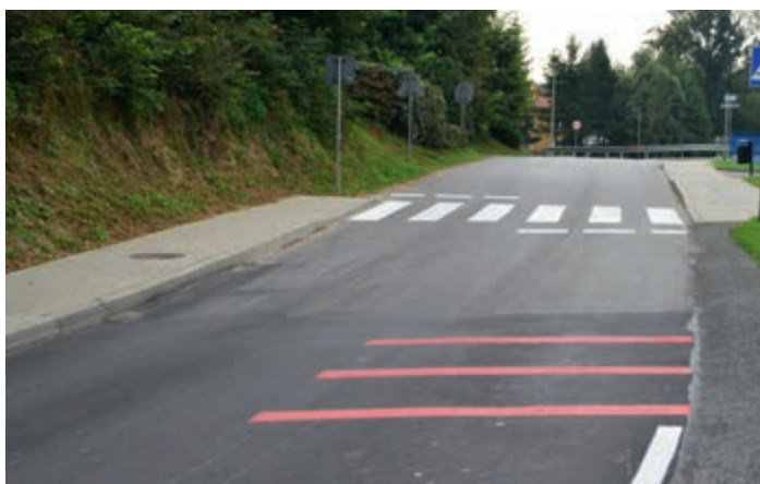
Przebudowa drogi w Głowience
