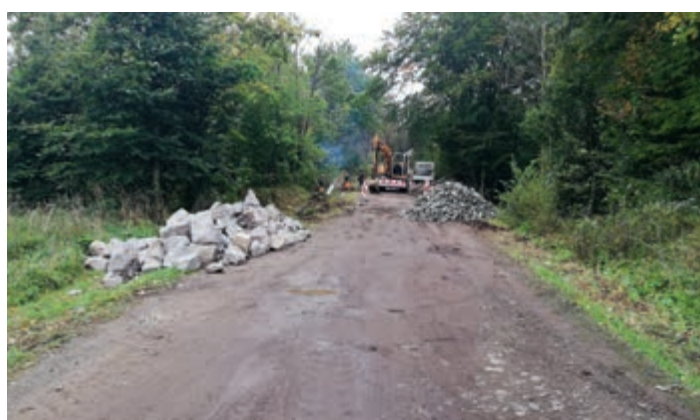
Remont drogi w Woli Niżnej i Woli Wyżnej – remont trwa
