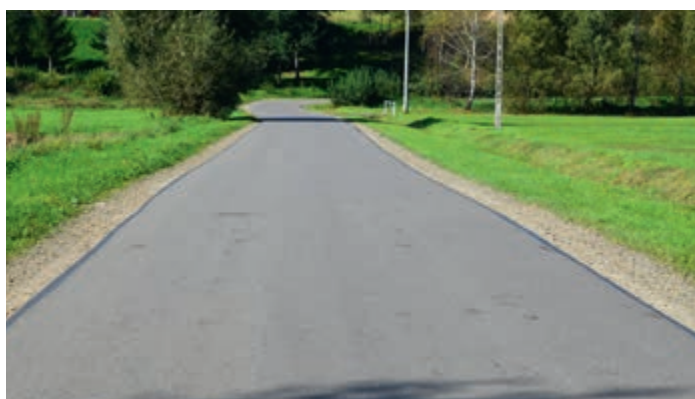
Remont drogi w Niżnej Łące – ul. Sportowa
