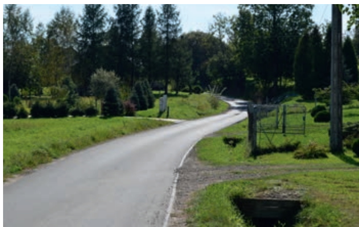
Remont drogi we Wrocance i Równem
