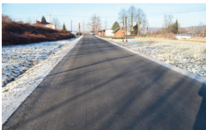
Remont drogi w Przybówce
