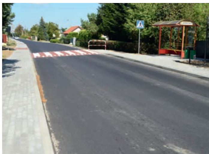
Przebudowa drogi polegająca m.in. na wykonaniu nowej nawierzchni w Głowicze i Wrocance oraz budowie chodnika we Wrocance
