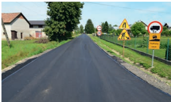
Remont drogi w Bajdach
