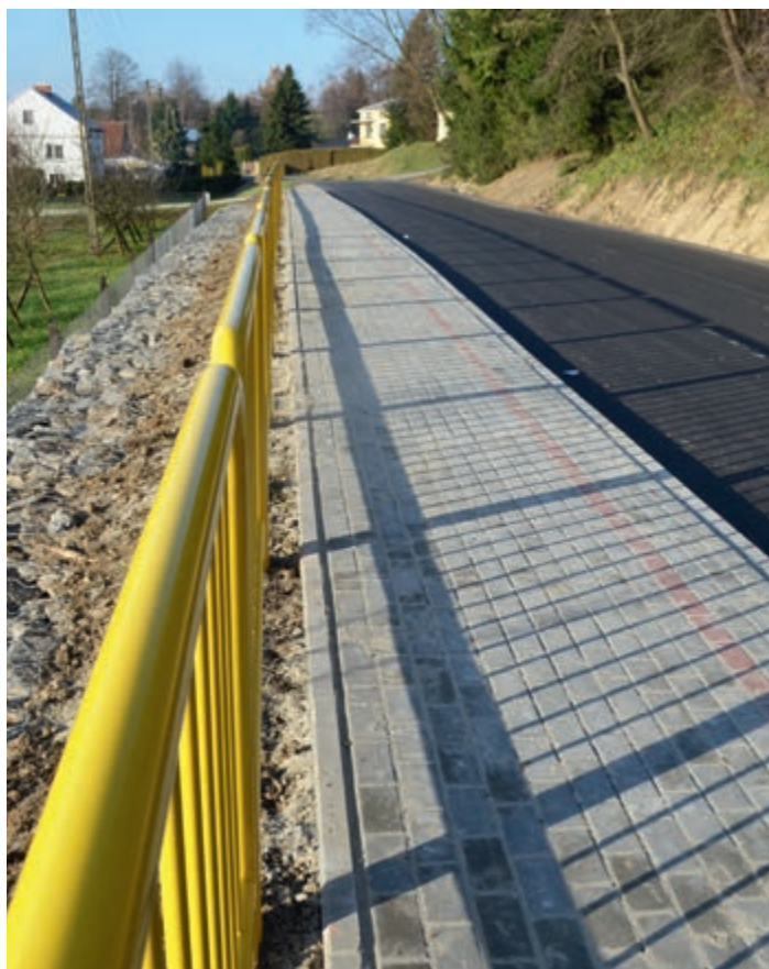
Przebudowa dróg w Przybówce i Wojaszówce
