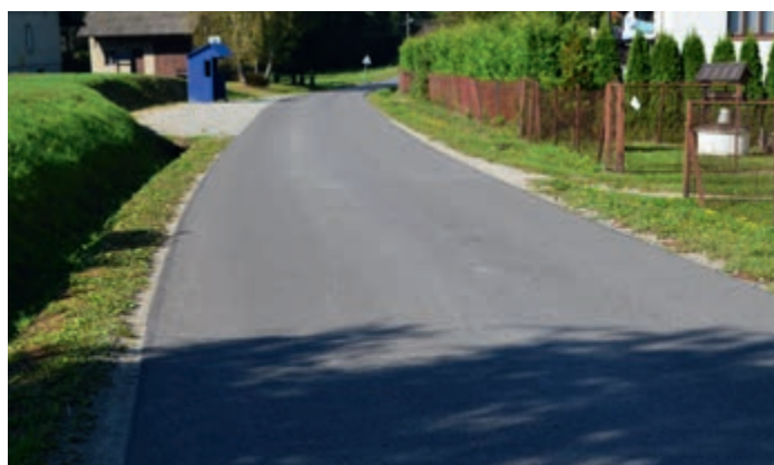
Nowa nawierzchnia drogi w Korczynie – ul. Spokojna
