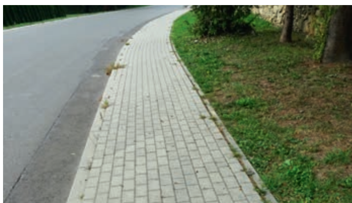
Budowa chodników w Wojkówce i Bratkówce
