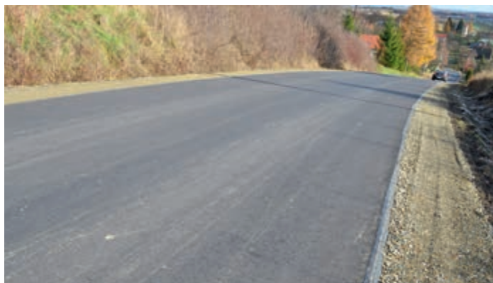
Przebudowa drogi w Chorkówce i Leśniówce
