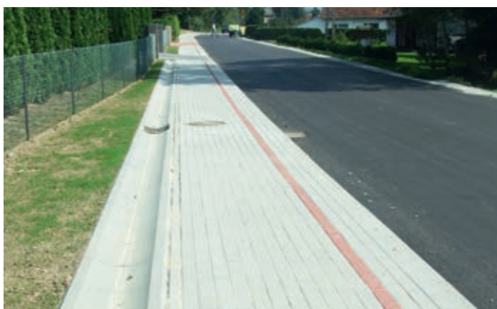
Przebudowa drogi wraz z budową chodnika w Przybówce
