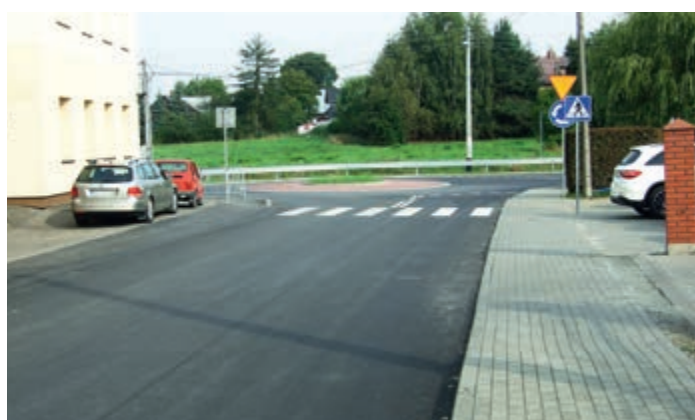
Przebudowa drogi wraz z budową skrzyżowania w Odrzykoniu
