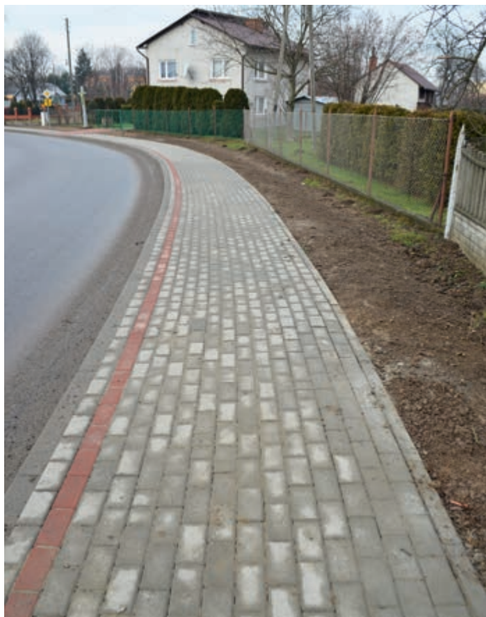
Przebudowa drogi wraz z budową chodnika w Jedliczu – ul. Sikorskiego
