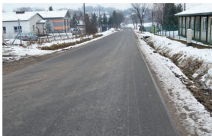
Remont drogi w Miejscu Piastowym
