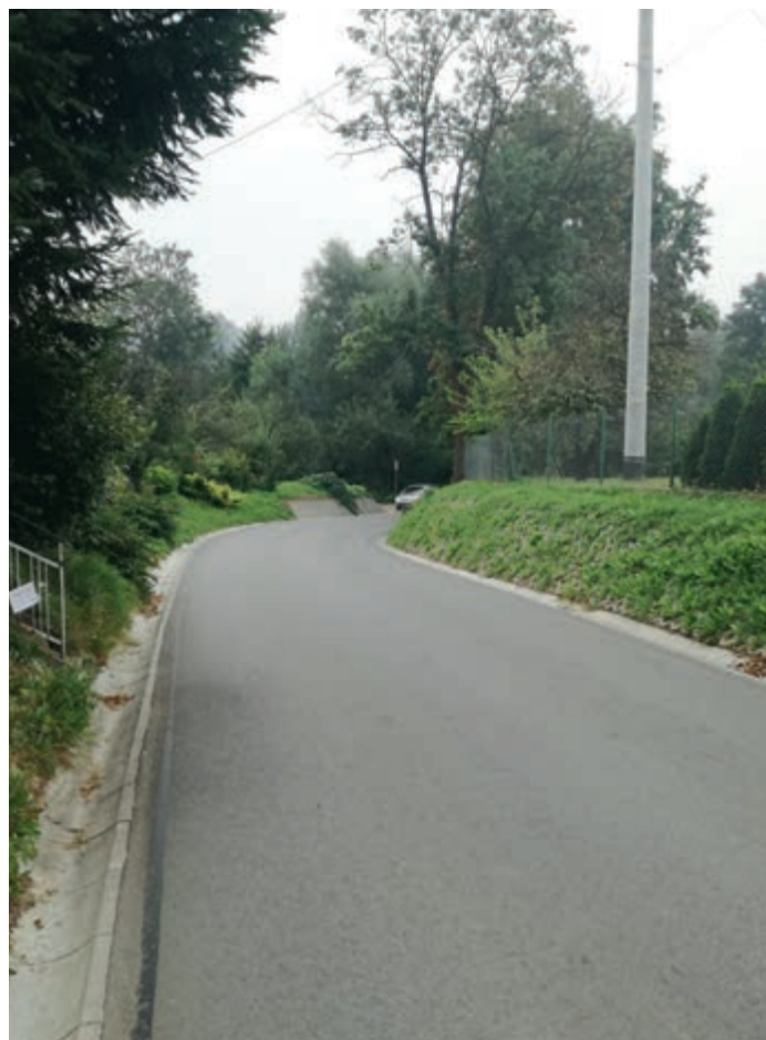
Remont drogi Szczepańcowa – Głowienka (ul. Anzelma Kubita)
