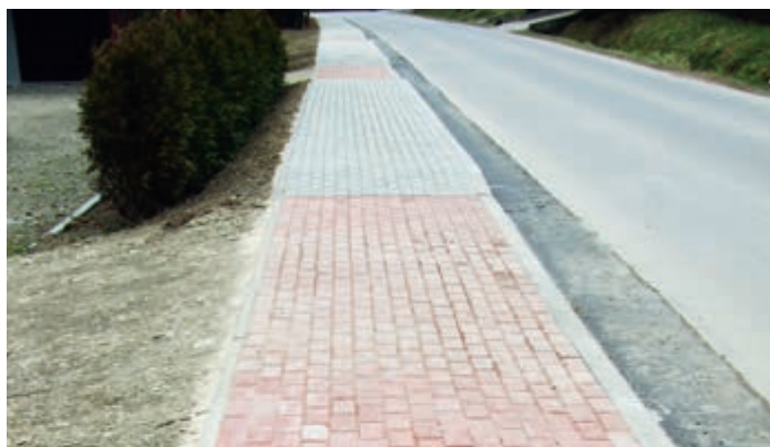
Przebudowa drogi oraz budowa chodnika w Głojskach
