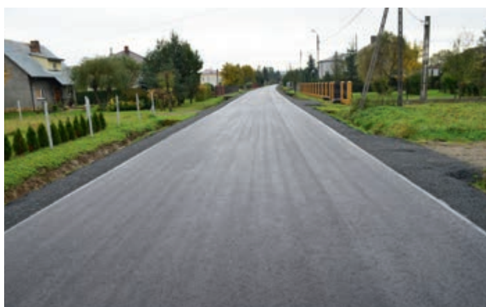
Remont drogi w Chlebnej
