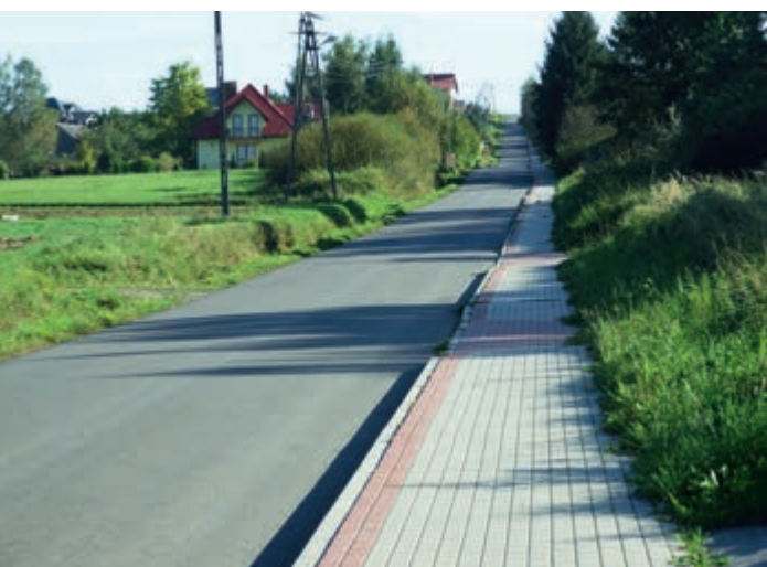
Przebudowa drogi polegająca m.in. na wykonaniu nowej nawierzchni, budowie chodnika w Krościenku Wyżnym – ul. Marynkowska
