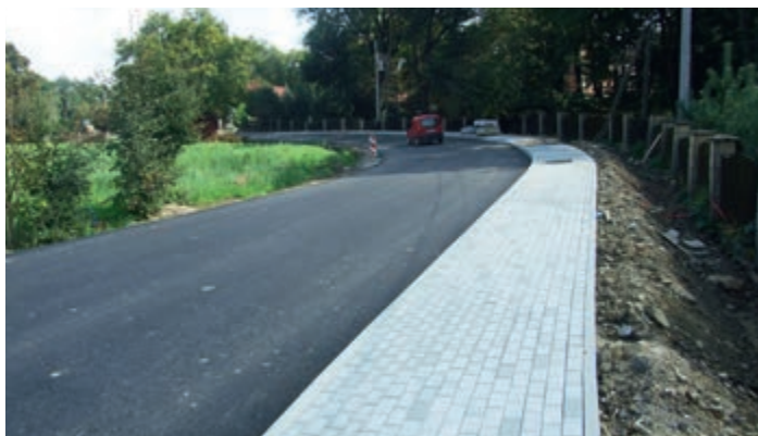
Przebudowa drogi wraz z budową chodnika w Klimkówce – remont trwa
