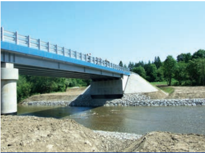
Budowa mostu w Zawadce Rymanowskiej
