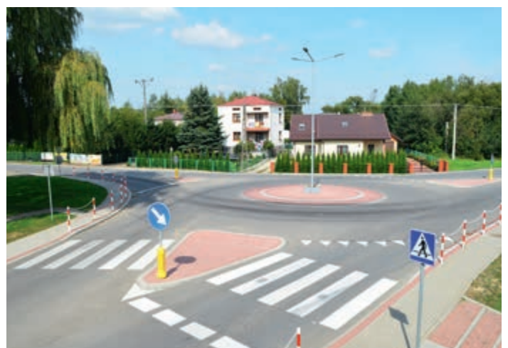
Przebudowa drogi polegająca m.in. na wykonaniu nowej nawierzchni w Zręcinie i Chorkówce, budowie chodnika w Chorkówce i Zręcinie oraz przebudowie skrzyżowania typu rondo w Chorkówce
