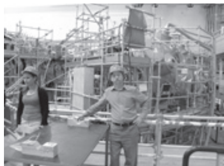
Stellarator Wendelstein 7-X w budowie
