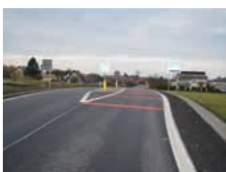
Przebudowa dróg – strona 8
