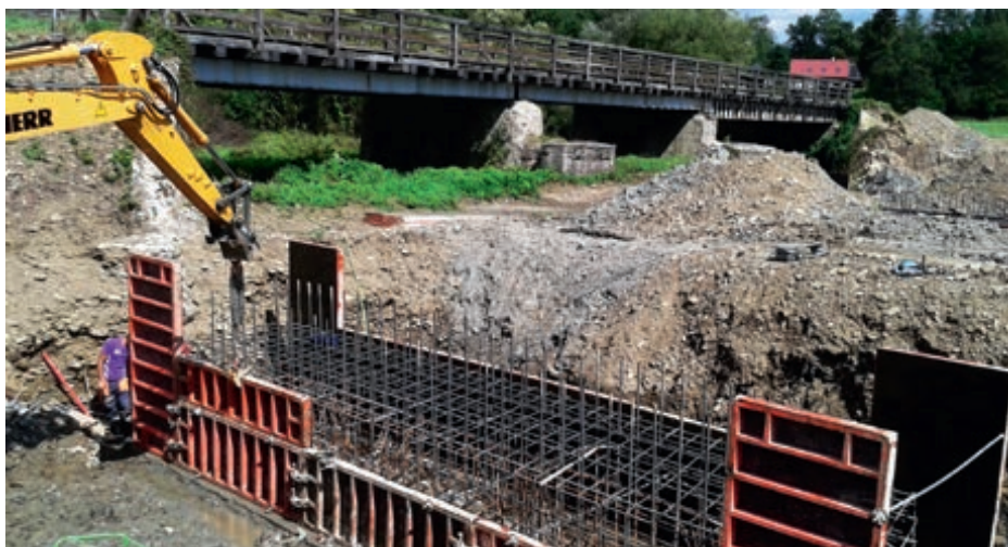
Trwają prace przy budowie nowego obiektu
