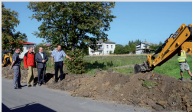
Mieszkańcy gminy Miejsce Piastowe z właścicielem FHU „Zalas”, która wygrała przetarg na budowę chodnika
