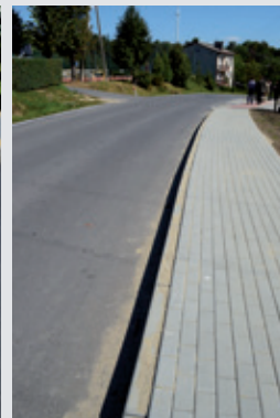
Wyręmontowana droga w Łękach Dukielskich
