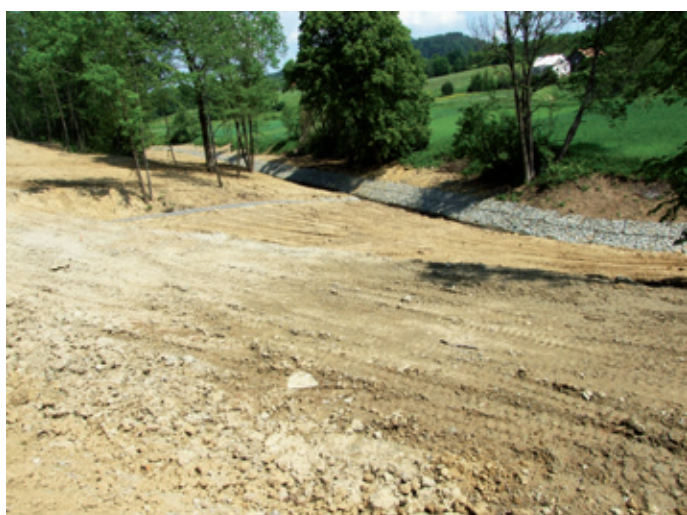
Stabilizacja osuwiska w Węglówce
