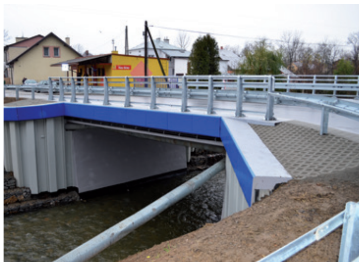
Most w Głowienice po remoncie
