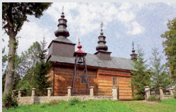
Prace remontowo-konserwatorskie w Zawadce Rymanowskiej
