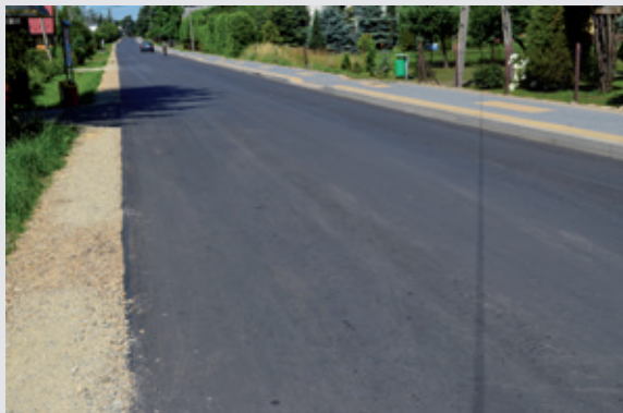
Przebudowa drogi w Krościenku Wyżnym
