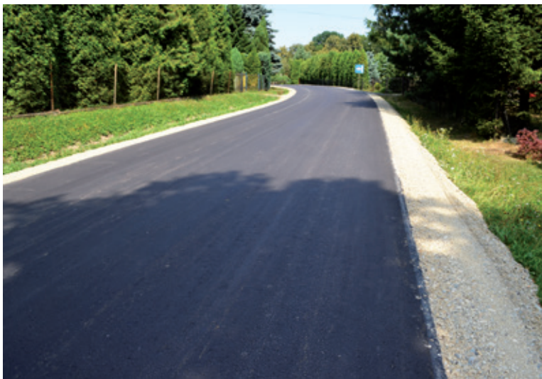
Droga Jedlicze – Żarnowiec po remoncie
