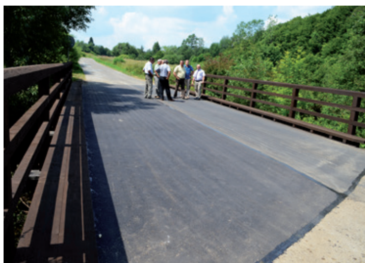
Przebudowa mostu w Bałuciance
