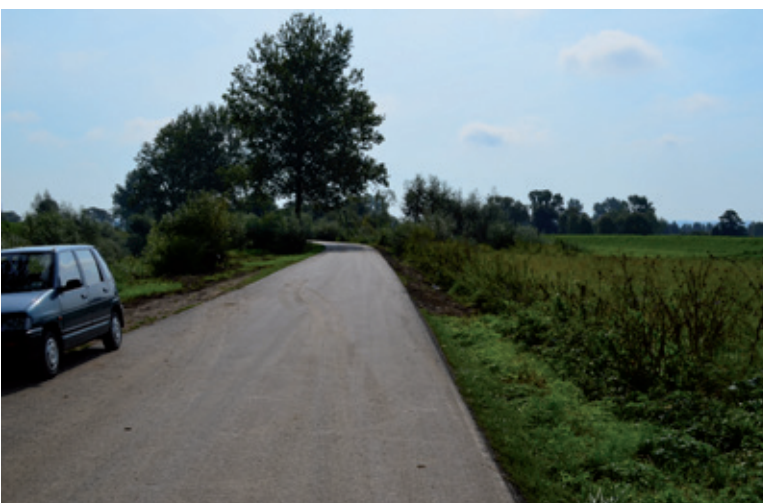
Przebudowa drogi w Bziance
