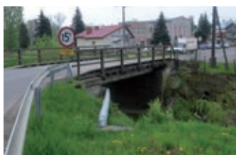
Remont mostu w Głowience – utrudnienia w ruchu – strona 5
