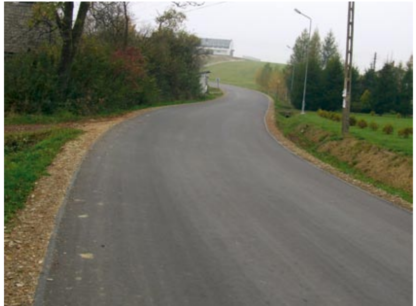
Nowa nawierzchnia na drodze powiatowej Olszyny – Jabłonica Polska
